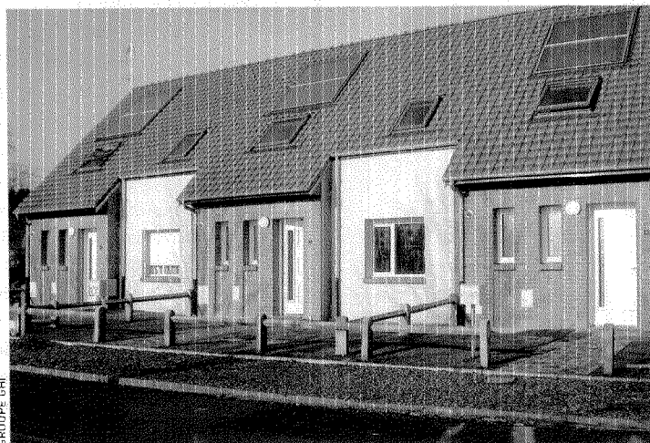
Les maisons Igloo de Fresnes-sur-Escaut sont équipées de panneaux solaires qui assurent la production d'eau chaude.
